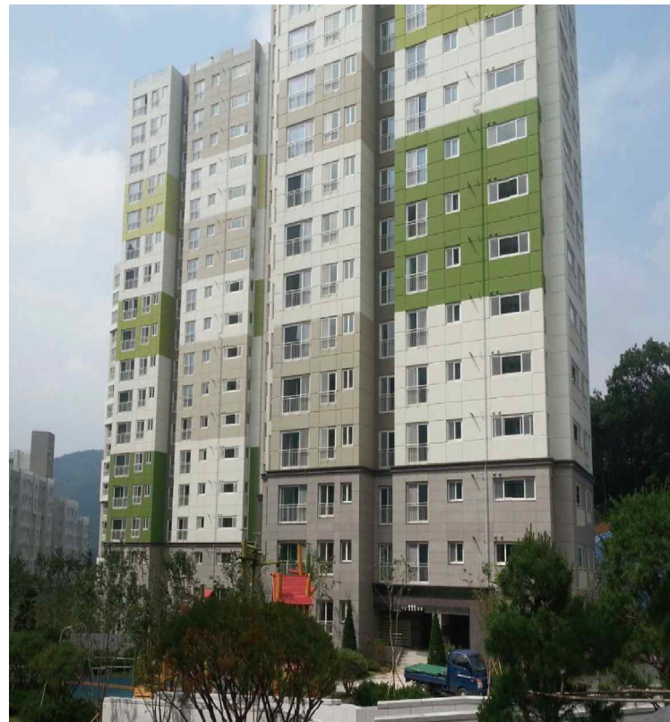
내곡1단지 아파트 신축 공사
