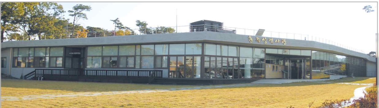
홍주성 역사관 건립 건축 공사
